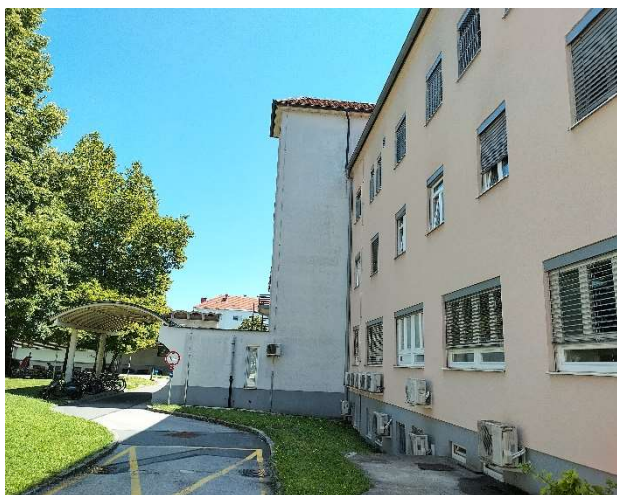
Slika 6: fotografije zahodne fasade T-objekta
